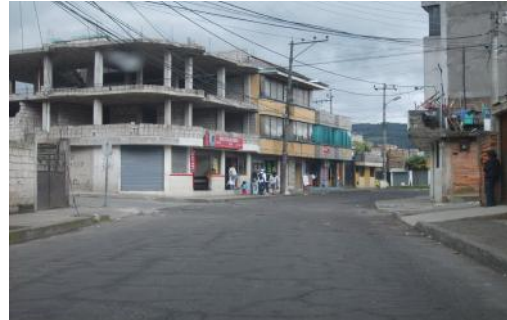
CALLE CARAPUNGO Y CALLE 6A Terrenos baldíos, poca iluminación y presencia de antisociales
