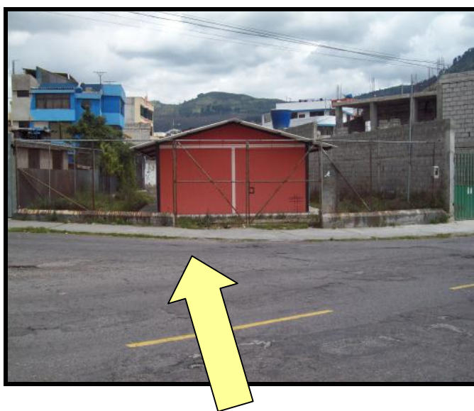
Casa comunal abandonada
