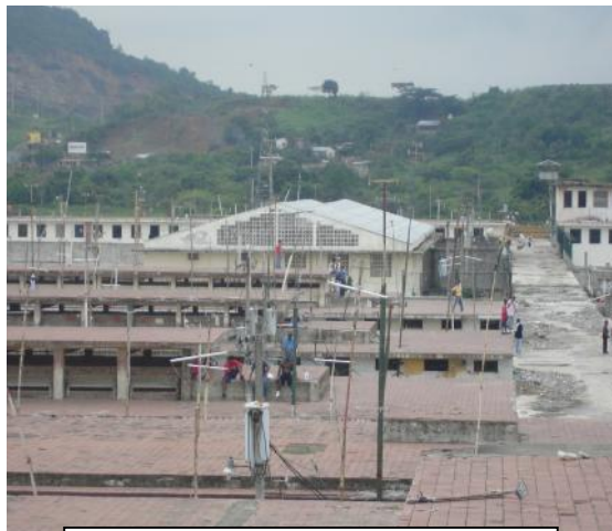
Barreras que fueron destruidos por los internos
